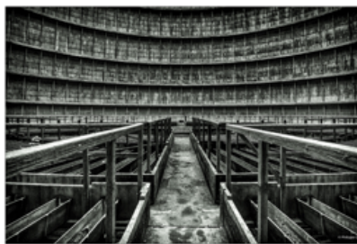
La Tour de Refroidissement
